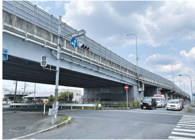
耐震補強・補修工事の進む国道165号新庄高架橋
