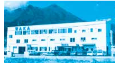
■麻績工場 (長野県) コネクタ、ケーブル加工・組立
